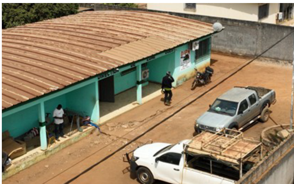
Photo 3 : Une vue du siège de la Direction de Zone Ouest à Man (Côte d'Ivoire)
