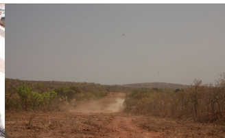
Le tracé de la nouvelle route internationale près de Kouroukoto
