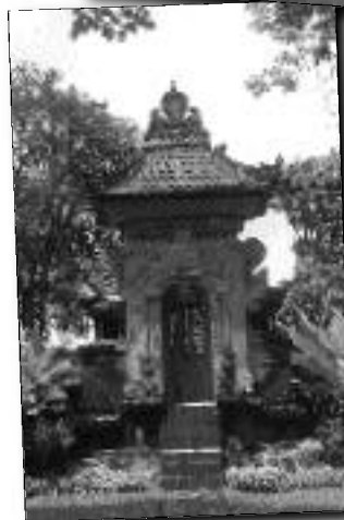
Ces structures du Jardin Botanique de Bali, Indonésie, sont en adéquation avec le style du jardin.
